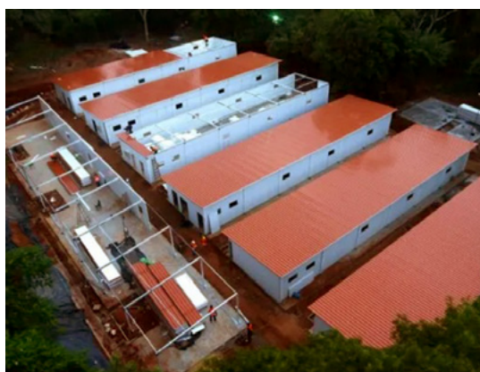
Construcción del 1er. pabellón de contingencia en el predio del INERAM 19
