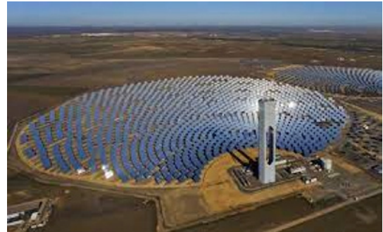
Figura N° 2. Planta de concentración solar (CSP) Cerro Dominador
