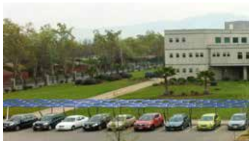
Figura N° 1 Propuesta de ubicación para el generador fotovoltaico en el estacionamiento de la Acapomil.
