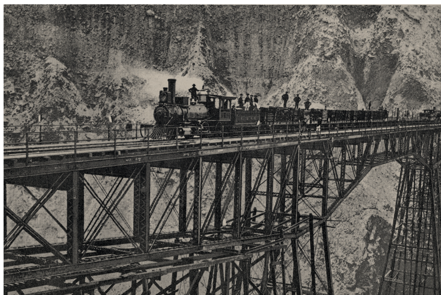
VISTA DEL VIADUCTO DE VERRUGAS. Memorias De A. Cáceres, Vol. II. P. 16.
